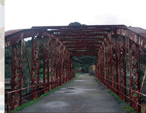
11 - Puente de Hierro (Iron Bridge)
